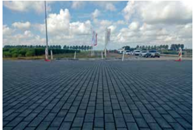
Schiphol Trade Park Ecotop Voegstenen GRN+ Bio Bound 21x10,5x8 antraciet normaal facet
